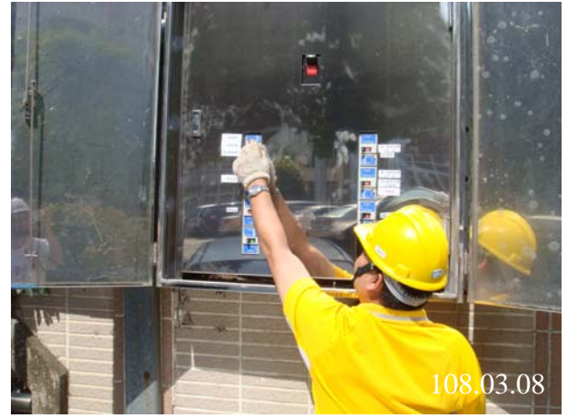
(安全防護組關閉總電源)
