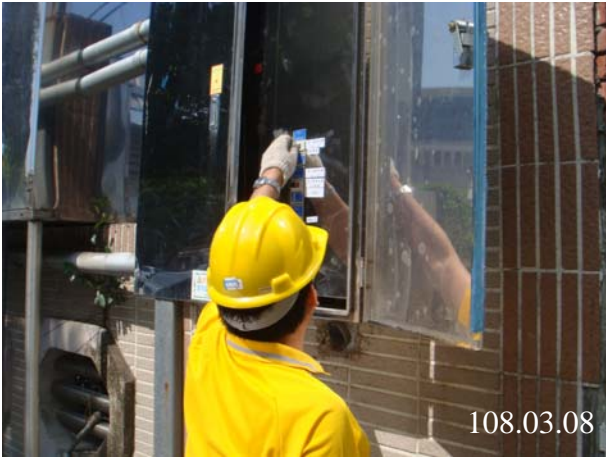
(安全防護組關閉總電源)
